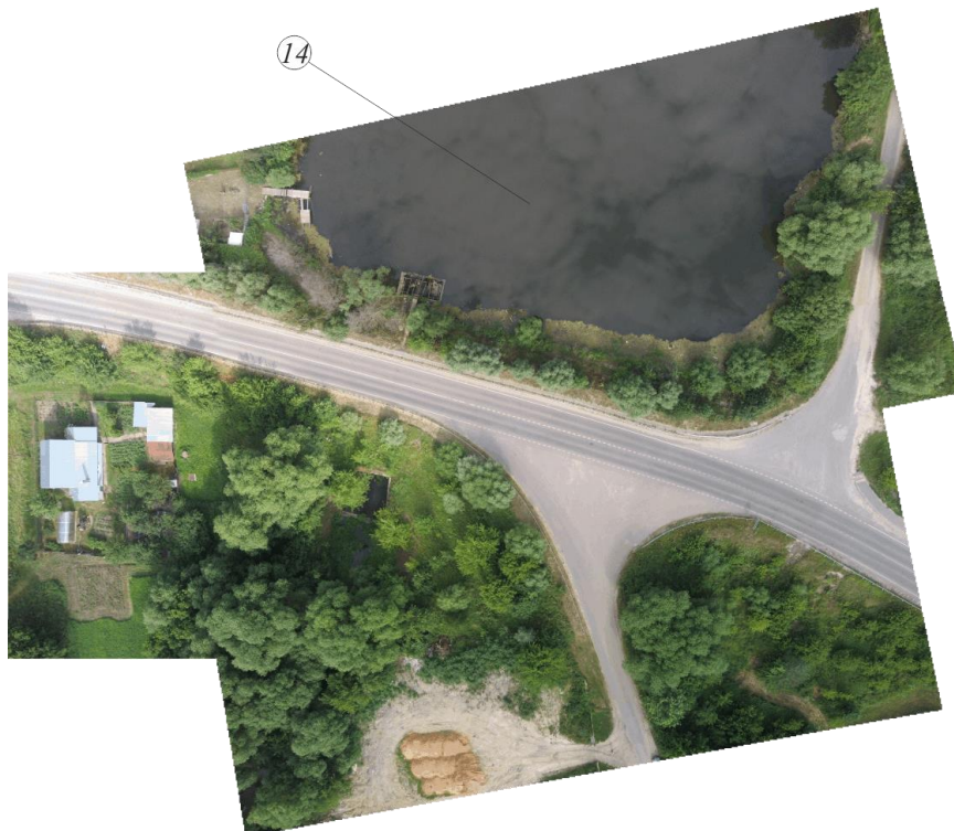
Рис. 6 – Ортофотопланы гидротехнических сооружений с отражениями: 14 – отражения облаков
