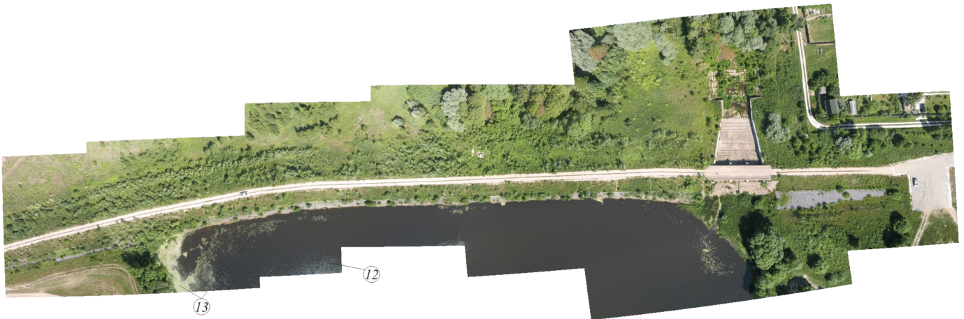
Рис. 5 – Ортофотопланы гидротехнических сооружений с бликами на водной поверхности: 12 – блики от солнца; 13 – водные растения
