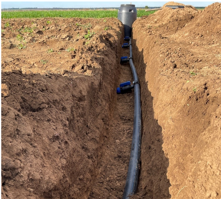
Рисунок 2 - Напорная и распределительная сеть системы кротового орошения DOI: https://doi.org/10.23649/JAE.2023.39.4.2
