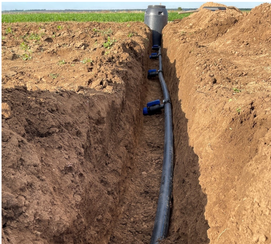
Рисунок 2 - Напорная и распределительная сеть системы кротового орошения
